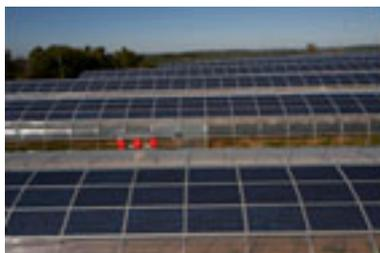
La structure spécifique de montage des panneaux solaires, brevetée par AmySOLAR, permet à l'aide d'une gouttière située en bas de chaque pan de **recupérer les eaux de pluie**, pour les acheminer dans des bassins de rétention et la rendre disponible pour l'arrosage des cultures.
