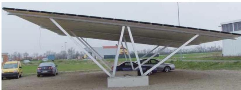
Une structure métallique ancrée dans des fondations béton surmontée de 45 modules photovoltaïques de 250 Wc chacun (9 rangées de 5 modules en pose paysage), permettant le stationnement de 6 véhicules et la recharge en simultané de 4 véhicules électriques.
